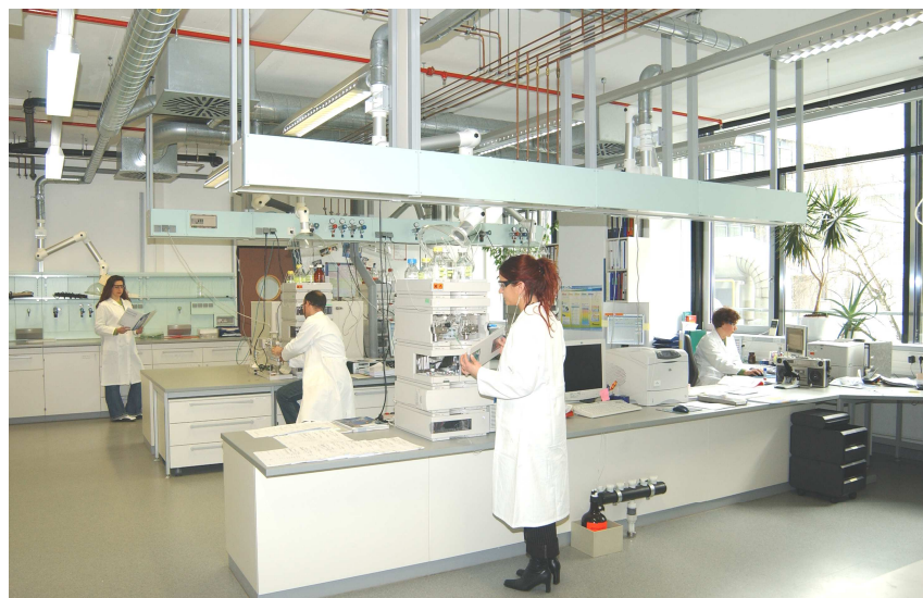
Bild 3: Arbeitssicherheit im Labor bestimmt den Betrieb der Lüftungsanlage
