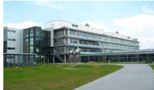
Neubau der Chemie und Kernchemie Mainz
